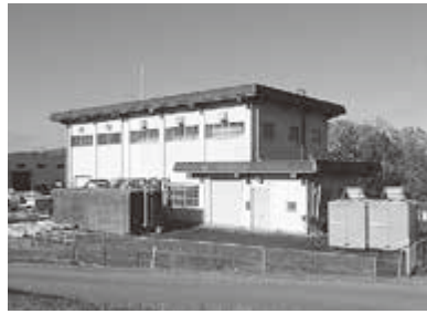
汁谷川排水機場
